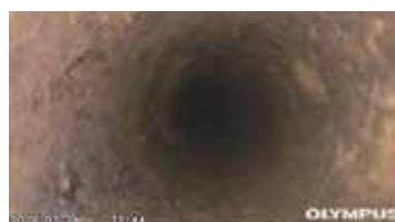
配管内部撮影画像
